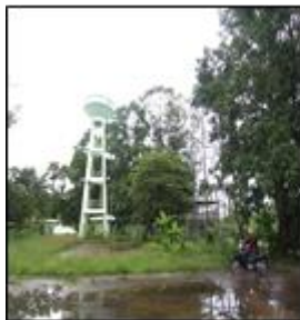
ระบบประปาหมู่บ้านแม่ก๊ะ เหนือ หมู่ที่ ๑
